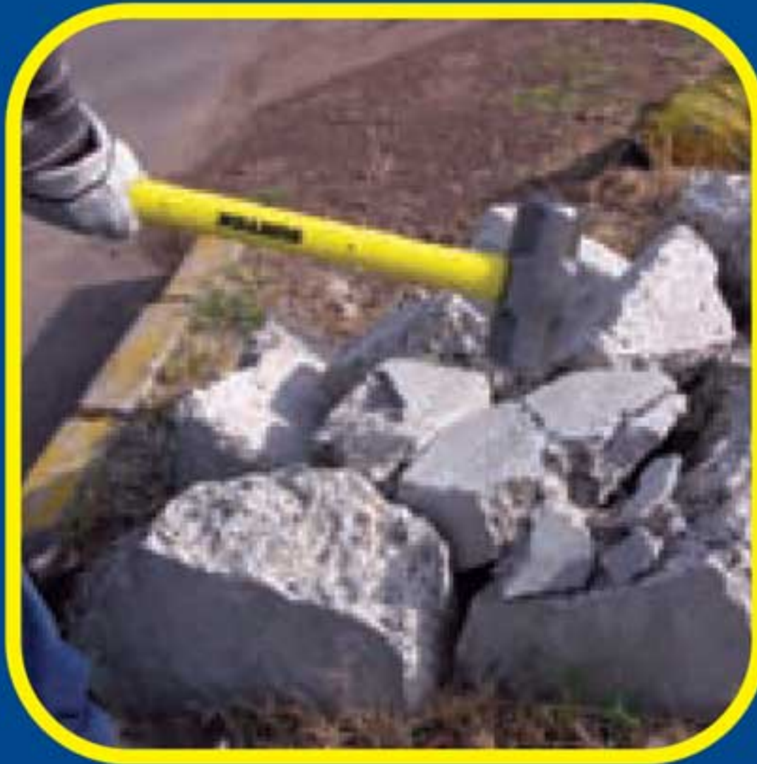
Romper-demoler concreto y piedra
